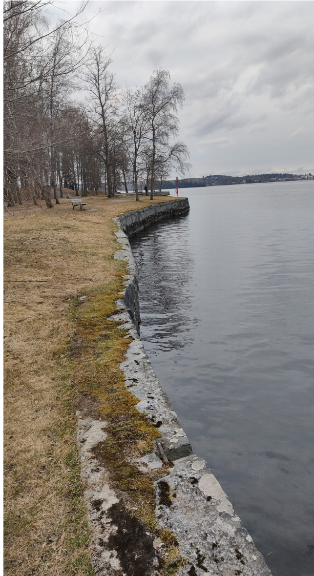
Kuva 2. Hatanpään puiston rantarakenteita.
